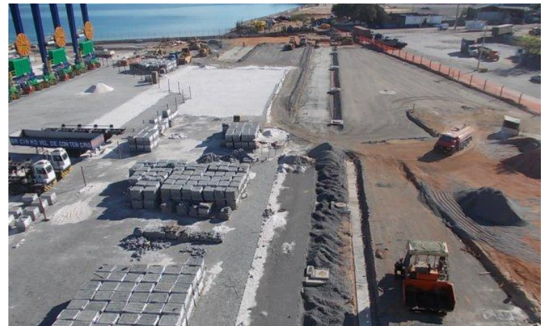
Pavimentação e nivelamento da retro-área (Maio/2012)
